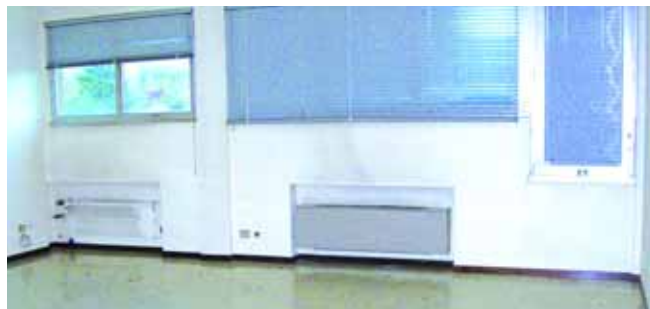
Lavori in corso nella cappella dell'ospedale
